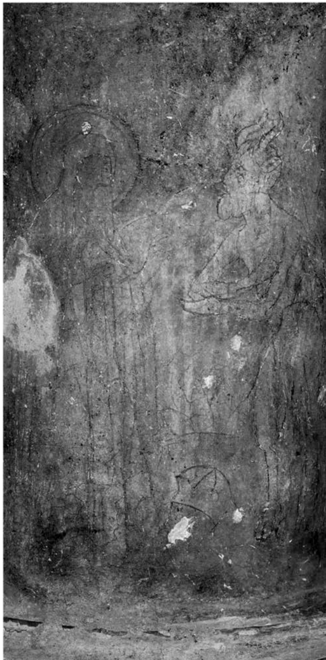
Крыльцо. Фрагмент. В процессе реставрации
