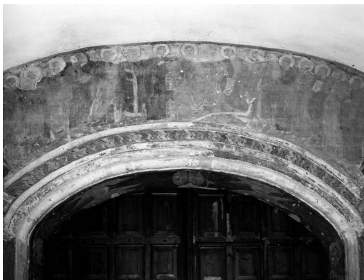
Деисус. Крыльцо. Фрагмент. После реставрации
