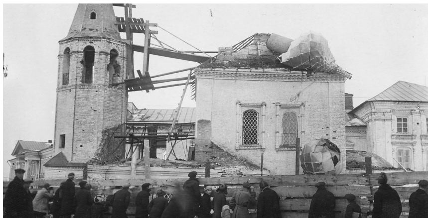
Разрушение церкви Воскресения на площадке. Фотография. 1930 г. Кострома. Костромской музей-заповедник
