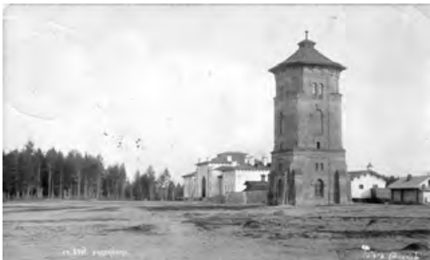
г. Буй. Водокачка
