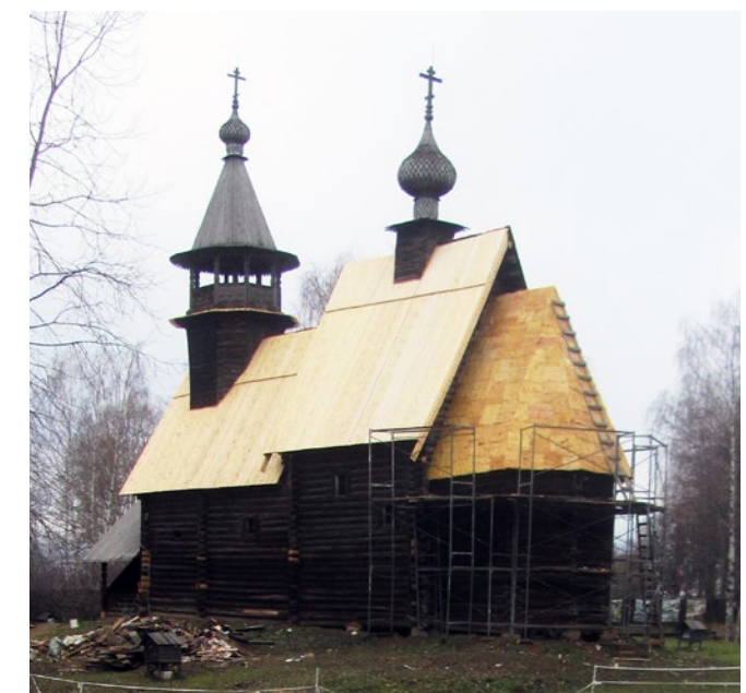
Работы по реставрации кровли церкви Всемилошного Спаса.
