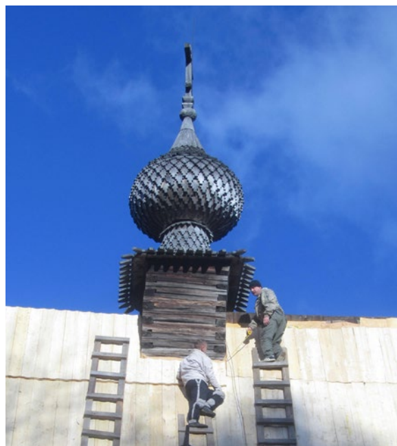
Закрепление тесин на крыше церкви Всемилошного Спаса.
